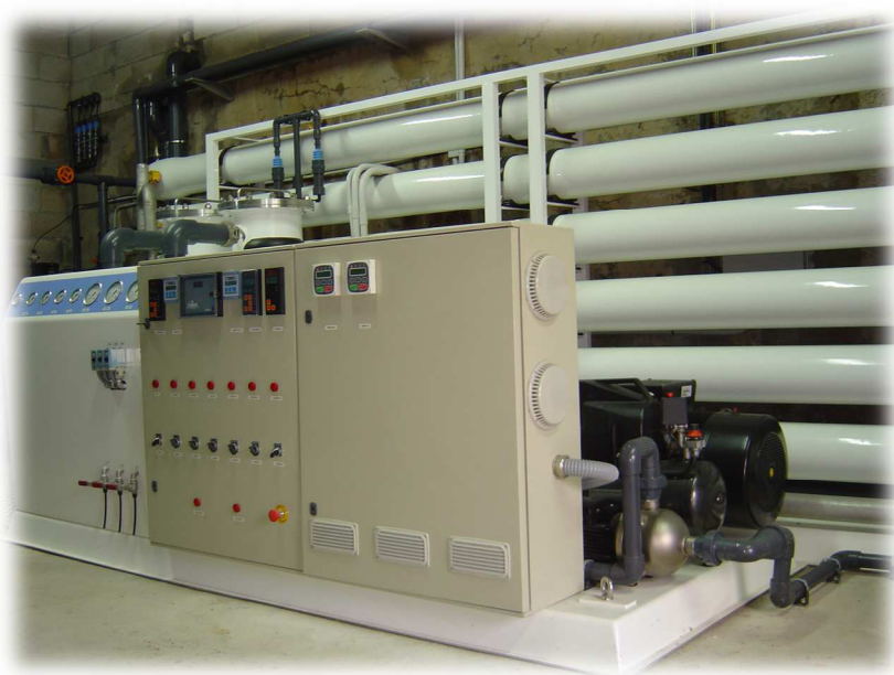
Equipo desalador de agua salobre modelo MA-575-R con sistema de recuperación de energía.
