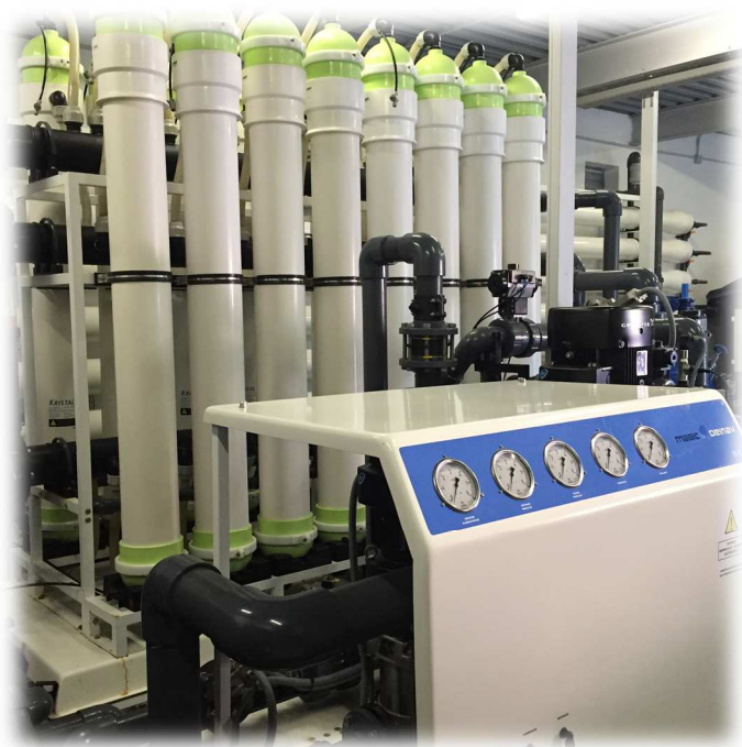
Equipo MAGIC de ultrafiltración de 950 m 3 /día.
