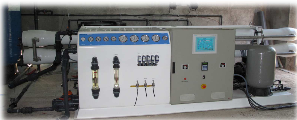
Equipo desalador de agua de mar PM-105 (modelo PM-S Compresor); Producción de 100 m 3 /día.
