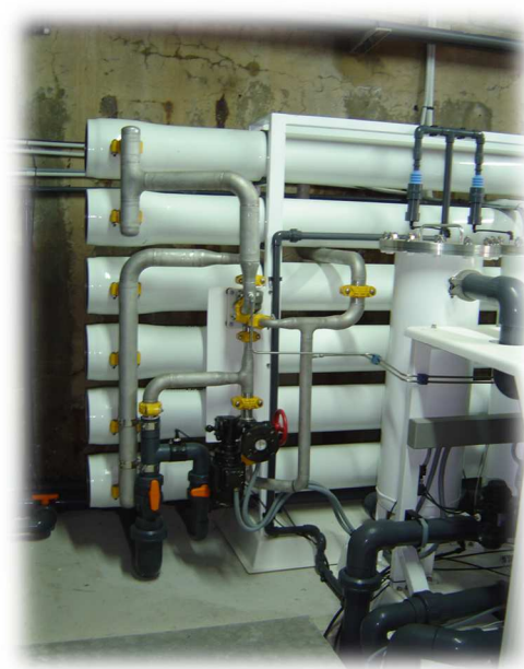
Equipo desalador de agua salobre modelo MA-575-R con sistema de recuperación de energía.
