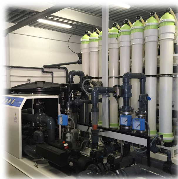
Equipo MAGIC de ultrafiltración de 950 m 3 /día.
