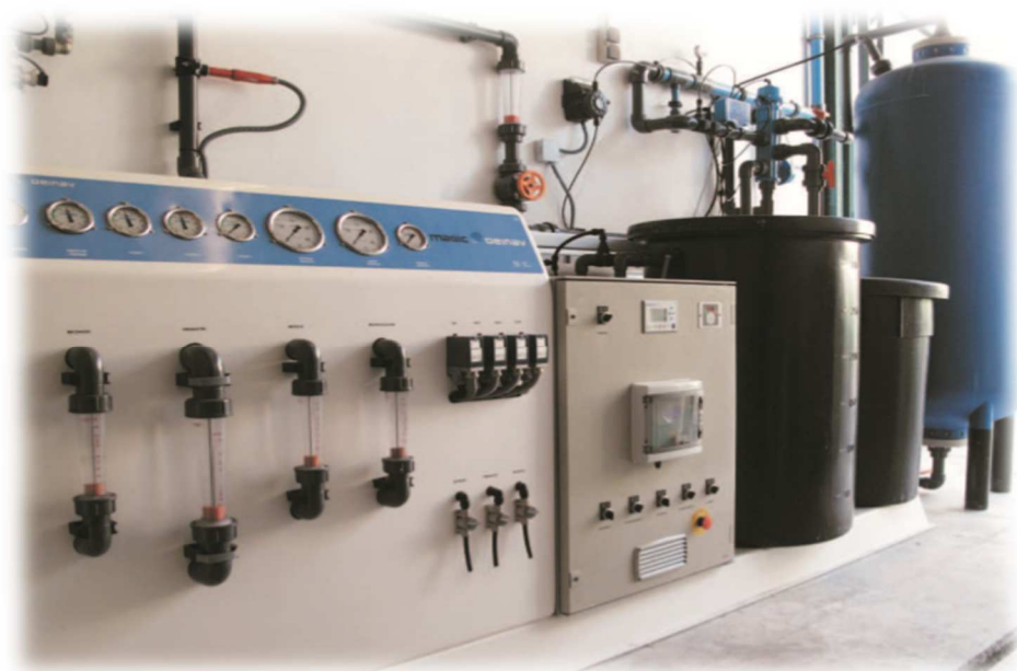
Equipo desalinizador. Modelo MA-60-L instalado en una destilería. Mallorca. Producción: 60 m³/día
